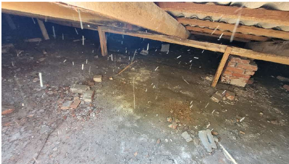
Fot. 5 – Widok na poddasze nieużytkowe (strych) z kominem nie wyprowadzonym ponad połac dachową
