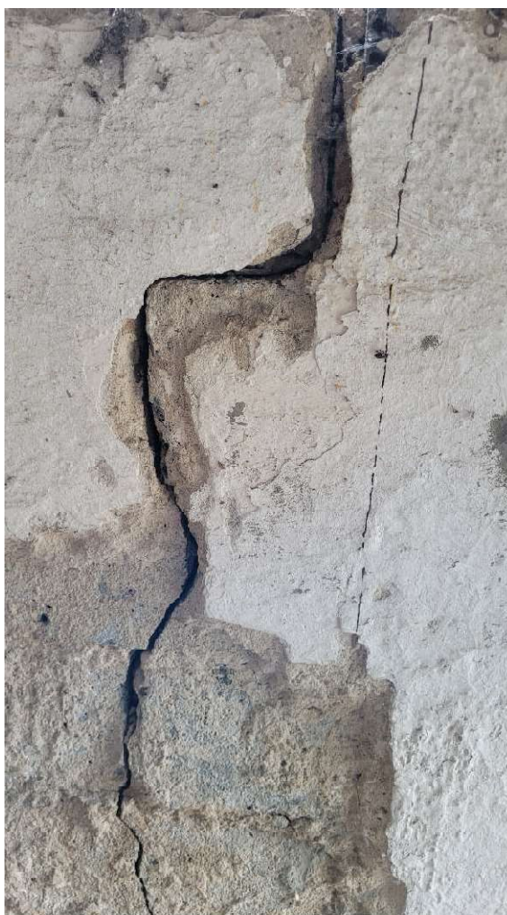
Fot. 6 – Widok na pękniętą ścianę elewacji południowej w pomieszczenie nr 4
